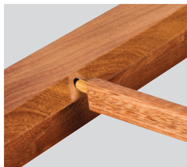
Petits bois extérieurs assemblés par tourillons et montés au cadre de l'ouvrant.
